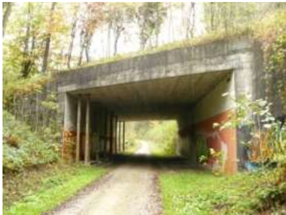
8) Zwangswechsel A52: Unterführung Jungholzstrasse 30m lang und 9 m breit.
