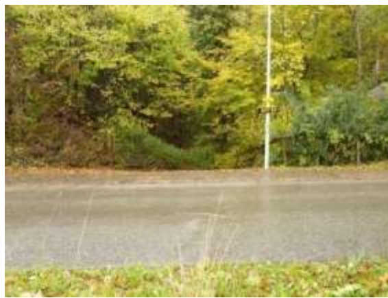
8) Regionale Verbindungsstrasse «Bachtelstrasse» mit Wildwechsel.
