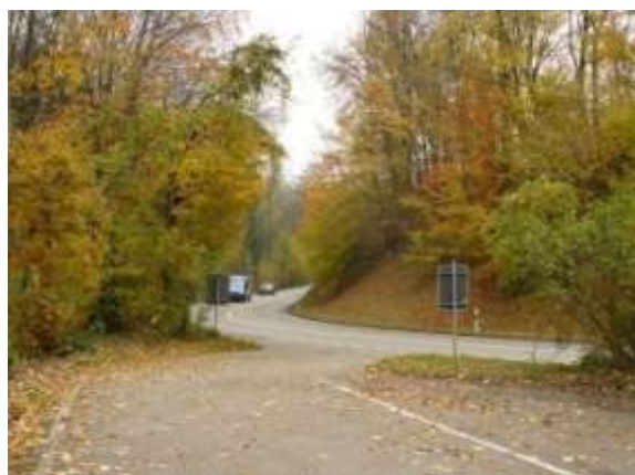
3) Hauptverkehrsstrasse «Weiacherstrasse» bildet mit ihrem hohen Verkehrsaufkommen eine Barriere für Wildtiere.
