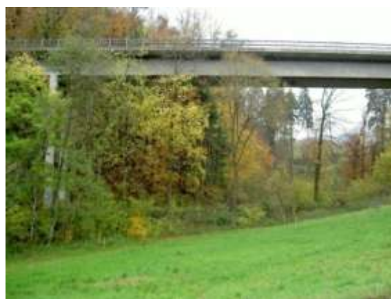
4/5) Zwangswechsel unter der Autobahnbrücke A52.
