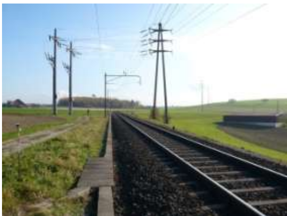
6) Einspurige Bahnlinie durch Pünt und Brunni.
