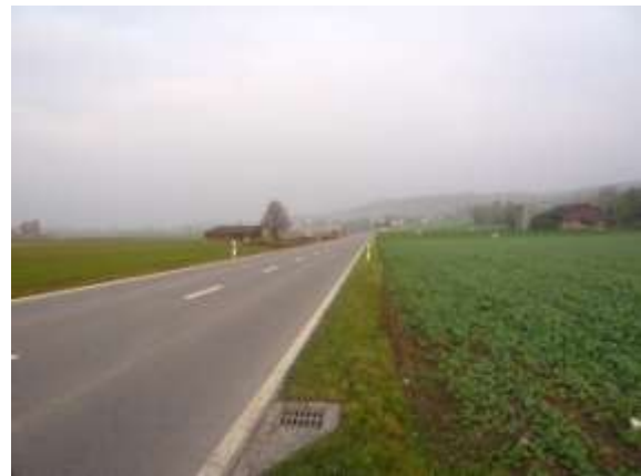
4/6) Regionale Verbindungsstrasse «Rudolfingen-Benken» mit Wildwechsel und fehlende Leitstrukturen über Bärchi.
