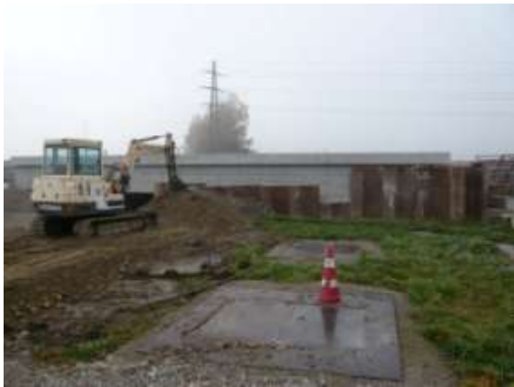
4) Wildtierunterführung Rietibach unter der A4 im Bau.
