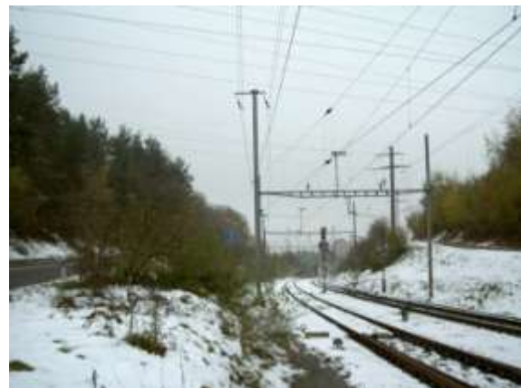
8) Zwangswechsel zwischen Birmensdorf und Industriebauten mit zweispuriger Bahnlinie und Hauptverkehrsstrasse.
