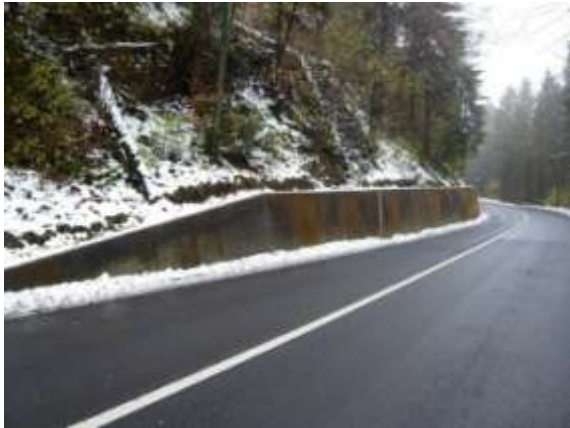
1) Mauer entlang der Chneusstrasse.
