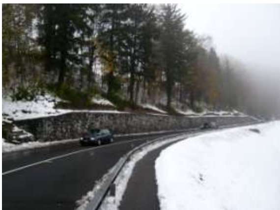
5) Mauern entlang der «Zugerstrasse».
