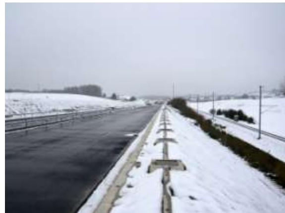
4) Hochleistungsstrasse A4 im Bau wird den Korridor für Wildtiere unpassierbar machen.
