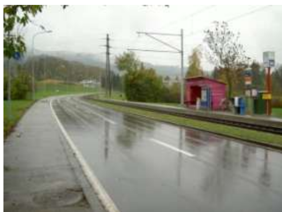
3/7) Regionale Verbindungsstrasse «Forchstrasse» und Forchbahn mit Wildwechsel.
