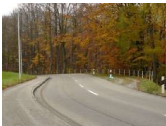
5) Regionale Verbindungsstrasse «Dättlikerstrasse» mit Wildwechseln.
