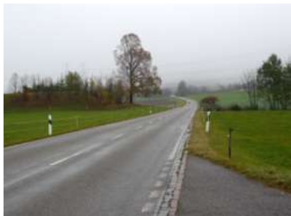
8) Regionale Verbindungsstrasse «Reitenbachstrasse» mit Wildwechsel.
