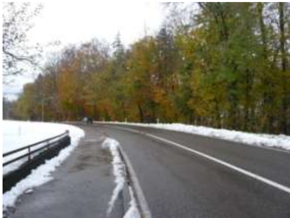
1) Hauptverkehrsstrasse «Binzstrasse» mit Wildwechsel.
