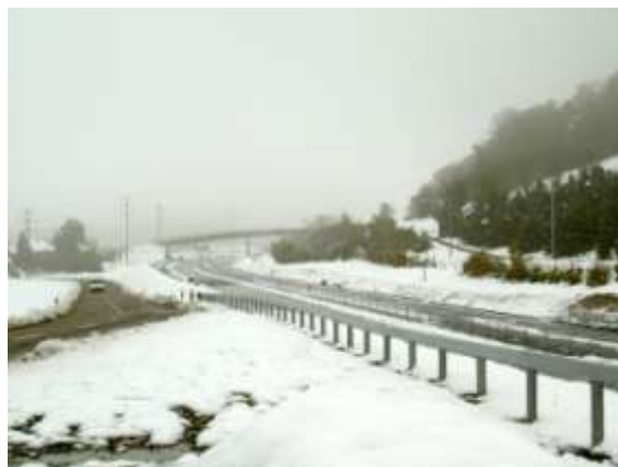
5/6) Hochleistungsstrasse A4 im Bau macht den Korridor für Wildtiere unpassierbar. Links regionale Verbindungsstrasse «Mettmenstetterstrasse».
