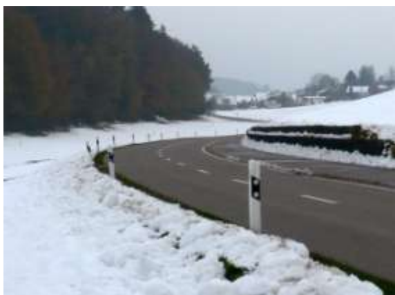
5/6) Regionale Verbindungsstrasse «Uttenbergstrasse» mit Mauer.
