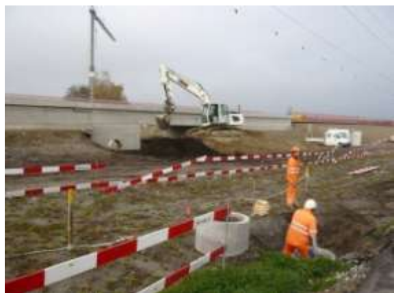
8) Wildtierunterführung Abistbach unter der A4 im Bau.
