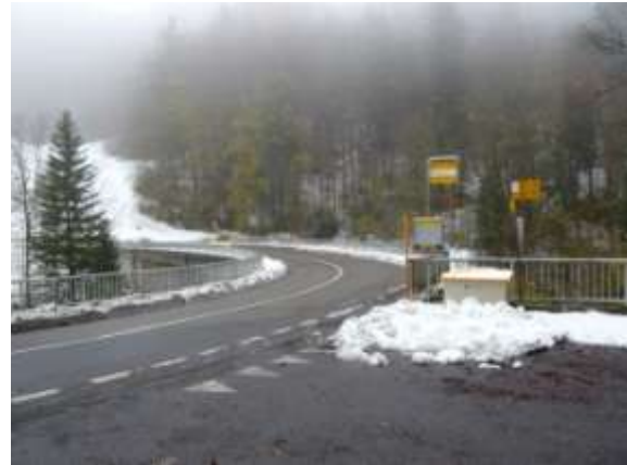
2) Regionale Verbindungsstrasse «Chneusstrasse» mit Wildwechsel.
