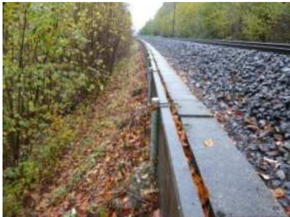
4) Mauer entlang der Bahnlinie.
