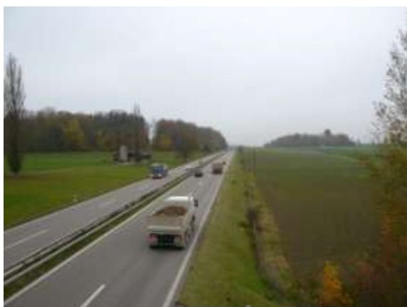
4) Hochleistungsstrasse A51 bildet für Wildtiere eine unüberwindliche Barriere.
