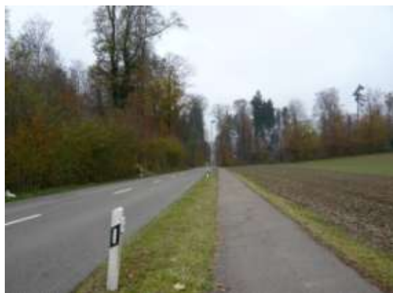
10) Regionale Verbindungsstrasse «Eigentalstrasse» mit Wildwechsel.
