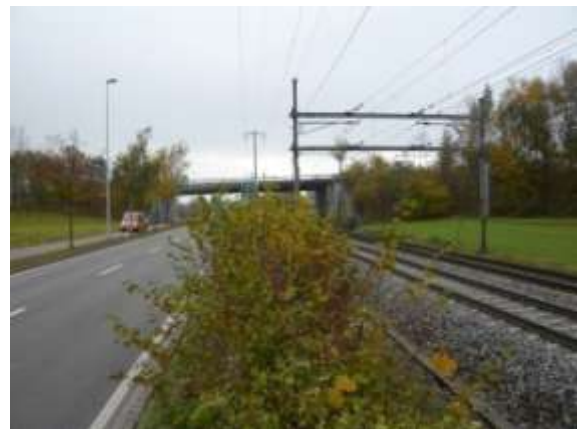
13/14) Hauptverkehrsstrasse «Kaiserstuhlstrasse» und zweisepurige Bahnlinie.
