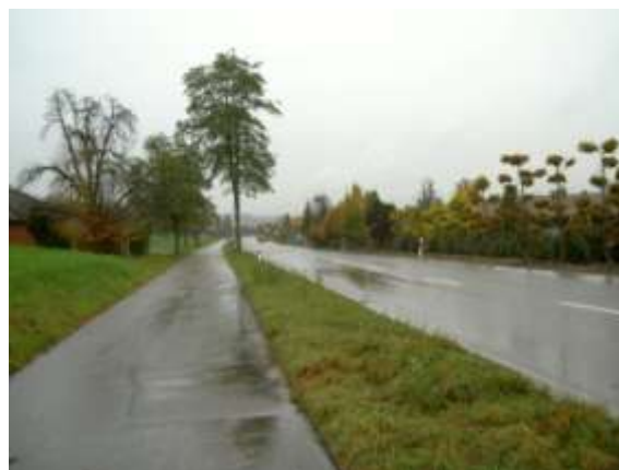
2) Zäune einer Baumschule erschweren den Wildtieren bei Neuhof den Durchgang.
