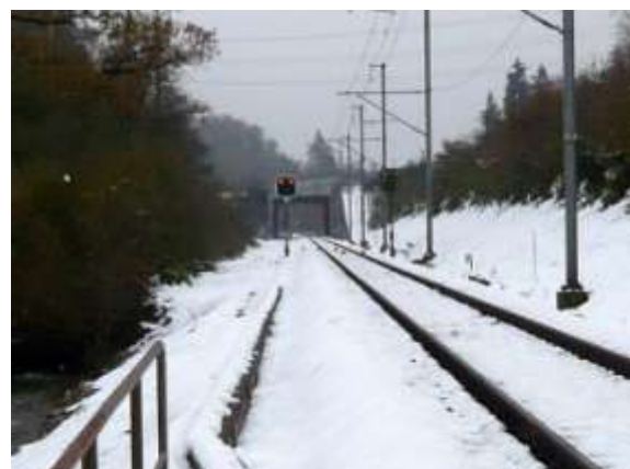
7) Einspurige Bahnlinie Mettmenstetten-Knonau.
