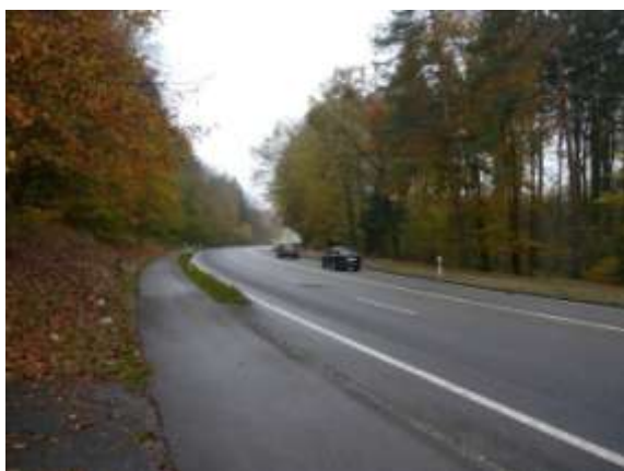
5) Regionale Verbindungsstrasse «Neue Winterthurerstrasse» mit sehr hohem Verkehrsaufkommen.
