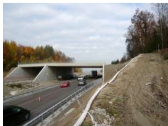
6/7) Hochleistungsstrasse A4 und Regionale Verbindungsstrasse Kleinandelfingen - Oerlingen zerschneiden den Korridor.
