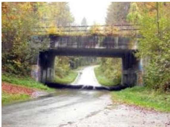
10) Zwangswechsel A52: Unterführung Tägernstrasse.
