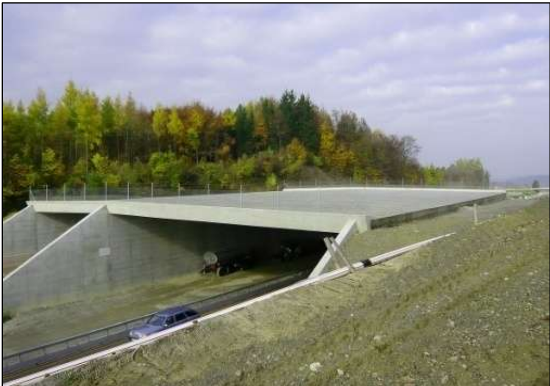
Abb.2 Neu erstellte, noch zu begrünende Wildtierquerung über die Hochleistungsstrasse A4 und die regionale Verbindungsstrasse Kleinandelfingen-Oerlingen im Wildtierkorridor ZH-15.
