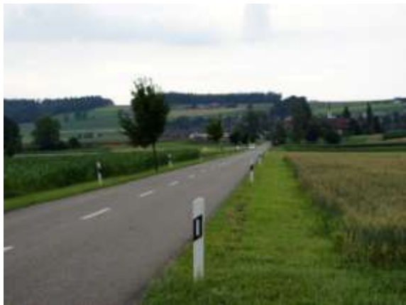
5) Hauptverkehrsstrasse Neufornerstrasse mit Wildwechsel.
