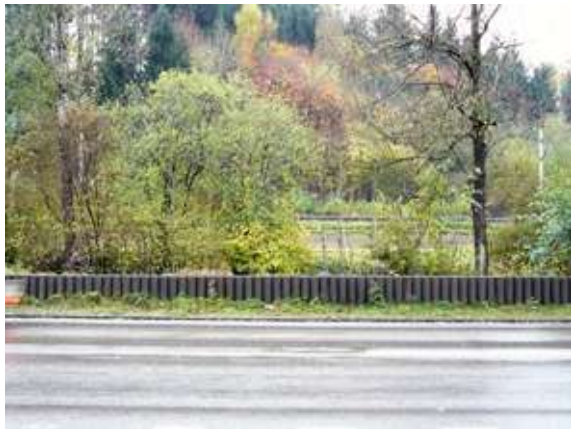
1) Multiples Hindernis bestehend aus Hauptverkehrsstrasse «Zürichstrasse», SBB-Linie Aathal und Aabach.
